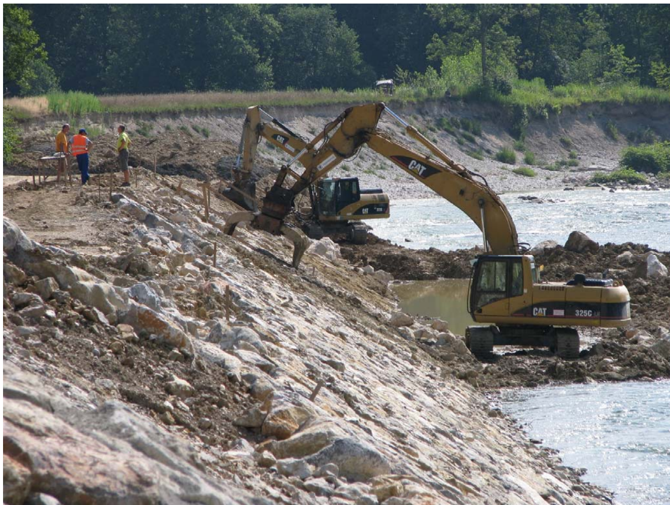
Slika 7: Gradbišče kamnometa v bližini gnezdilne stene breguljk na Savi pri Šentjakobu na dan 8.7.2011. Foto: Tomaž Jančar, DOPPS
