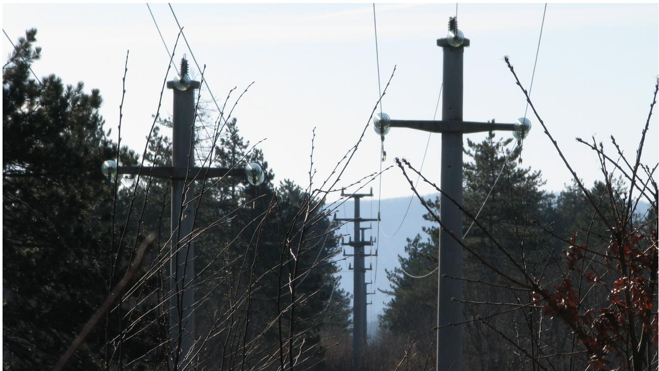
**Slika 21:** Nevarni betonski zatezni srednjenačetostni daljnovod z visečimi izolatorji med Lisičino in Škocjanom
