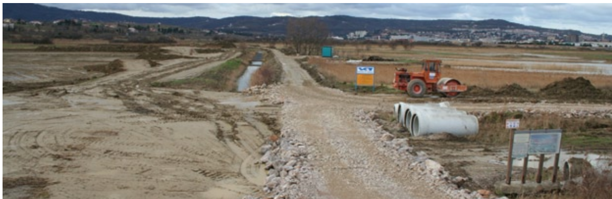
Obsežna obnovitvena dela so se na Bertoški bonifiki začela v začetku 2006. foto: Igor Brajnik
