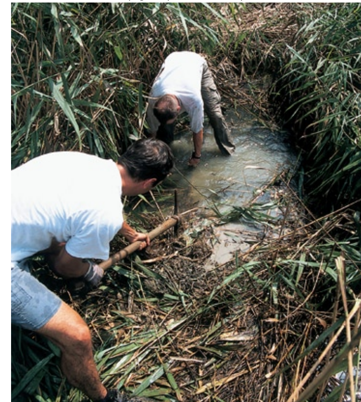
Odstranjevanje črnih zaježitev; foto: Borut Mozetič
