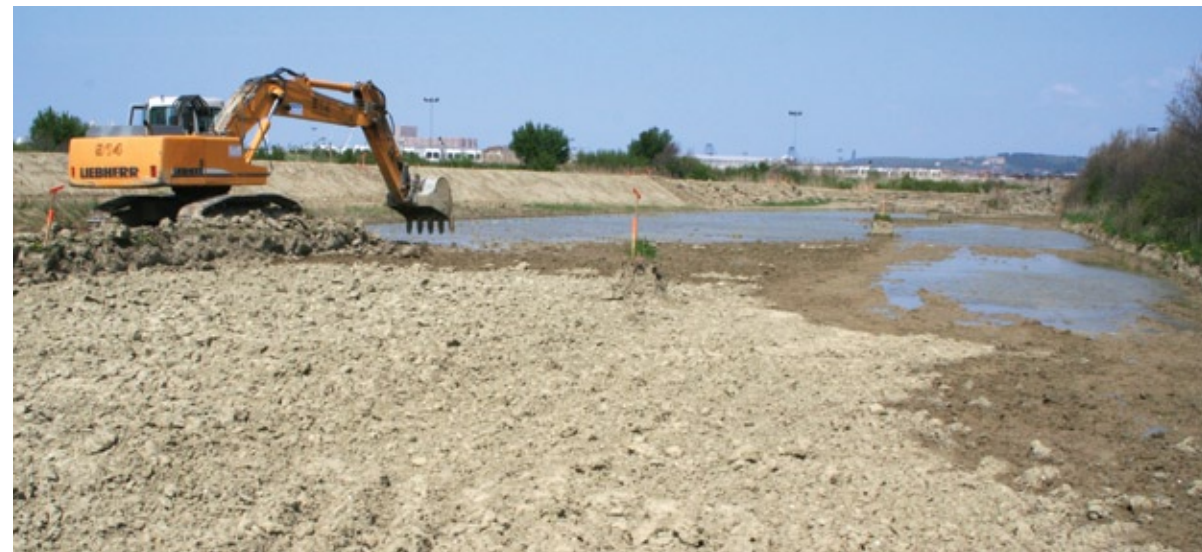
Poglobljanje severnega dela bonifike; foto: Borut Mozetič
