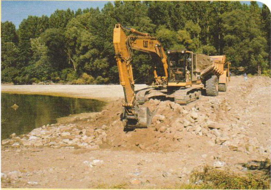
Baggereinsatz: Ein Altarm wird geöffnet
