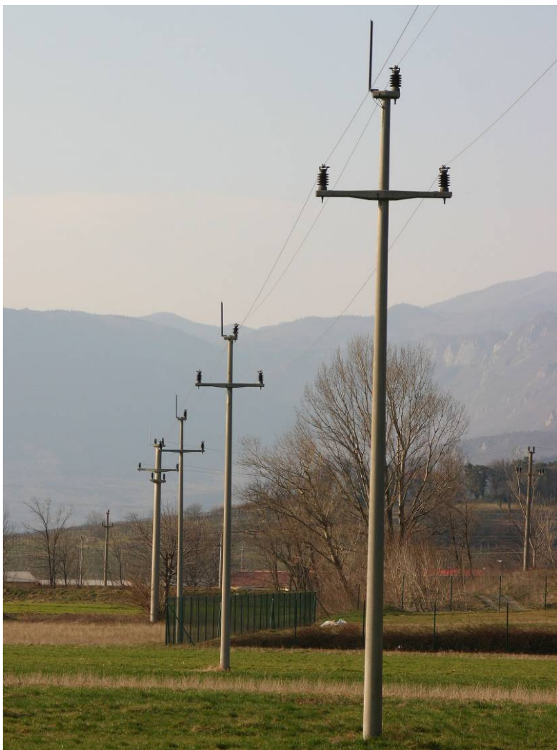
Slika 21: Vpliv daljnovodov na vrsto je velik predvsem zaradi neprimerne konstrukcije večine stebrov, ki se pojavljajo v nekem območju. Foto: T. Mihelič
