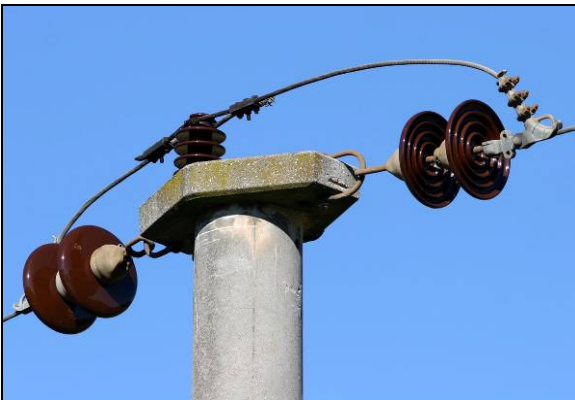
Slika 28: Primer zateznega stebra, kjer lahko prehod vodnika preko spebra rešujemo z uporabo izoliranega vodnika ali pa namestimo prečno konzolo in žico speljemo pod njo.
