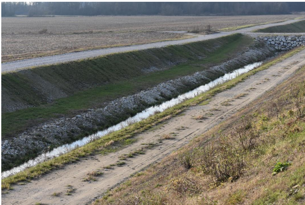
Slika 50: Drenažni kanal na desnem bregu ni urejen sonaravno
