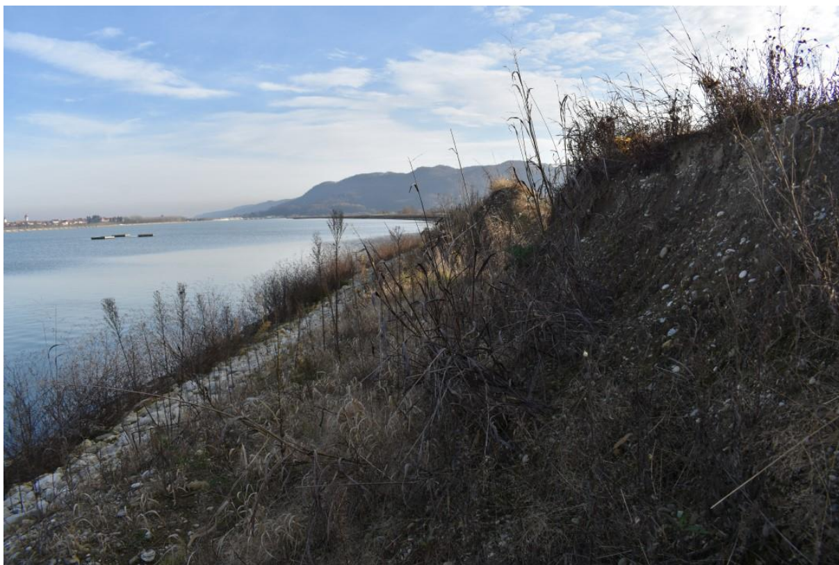
Slika 39: Ker se za stene ne skrbi, se le-te zaraščajo
