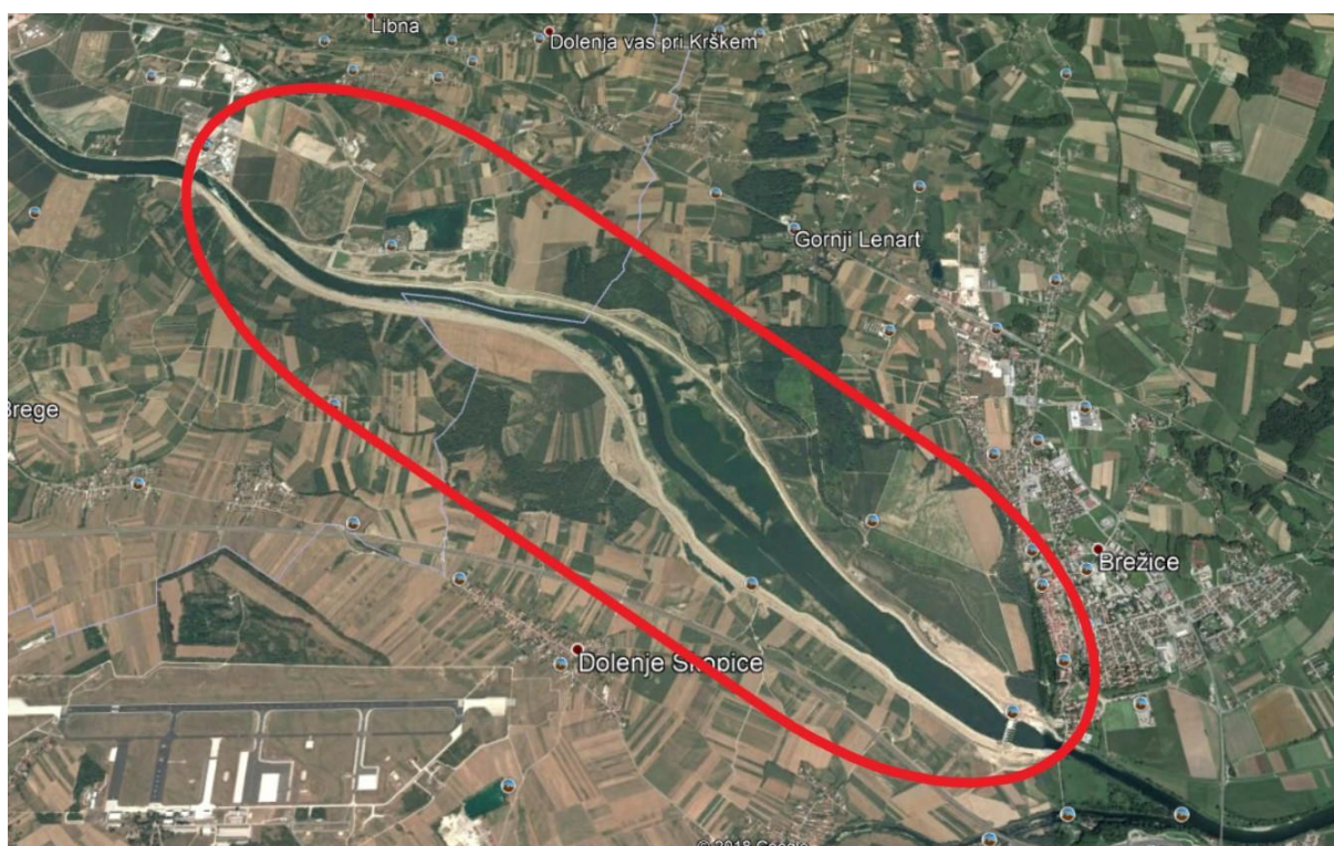
Slika 1: Območje gradnje HE Brežice
