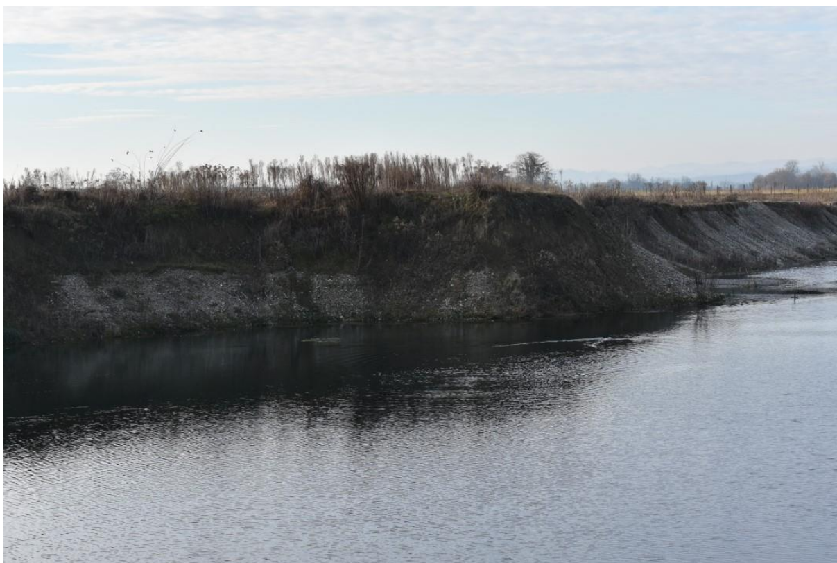
Slika 27: Porušene in zaraščene stene
