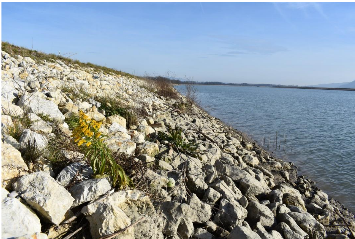
Slika 56: Brežine so utrjene s kamnitimi zložbami, nezasajene, ponekod že najdemo invazivno zlato rozgo ( Solidago sp. )
