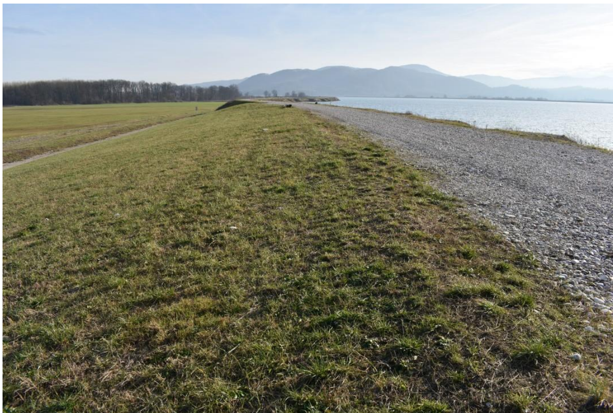
Slika 2: Širitev protipoplavnega nasipa
